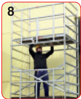
Si blocca con un click. Un solo movimento rapido e comodo.
